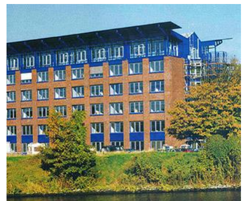
Standardkessel GmbH in Duisburg
